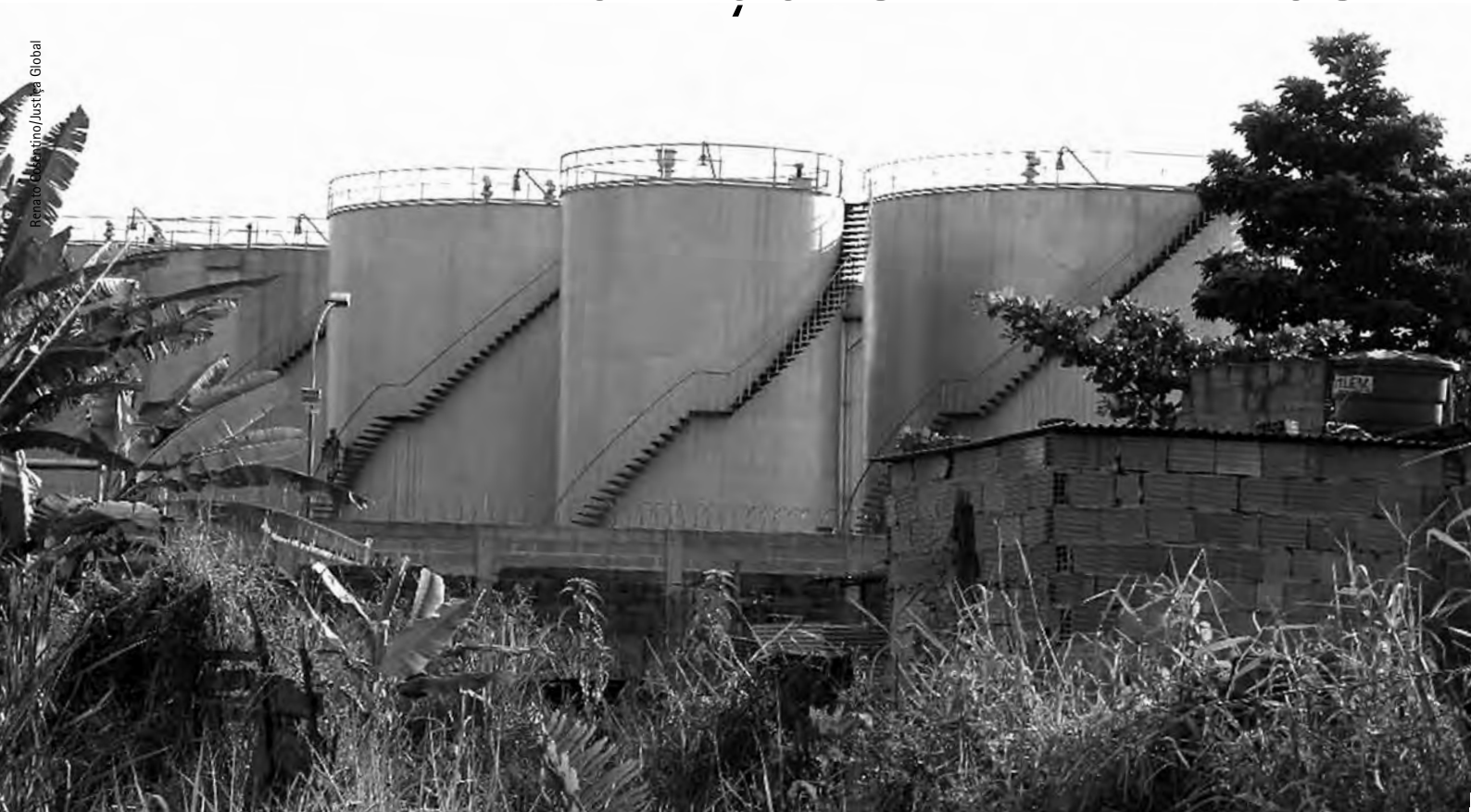
Mega projetos, como a Reduc (acima) e o Comperj, são instalados em territórios empobrecidos: subserviência aos interesses privados
